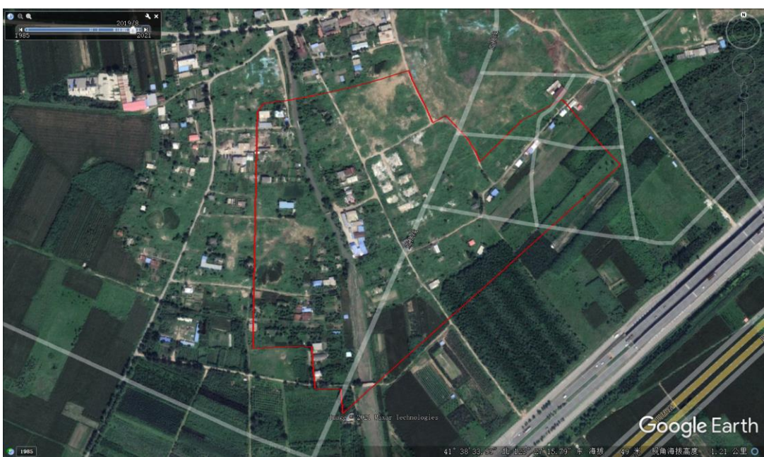
2019 年地块内建筑基本拆迁完毕
