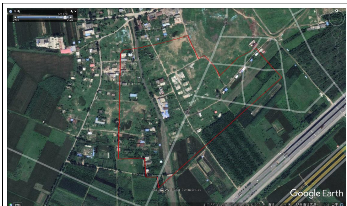
2019 年地块内建筑基本拆迁完毕
