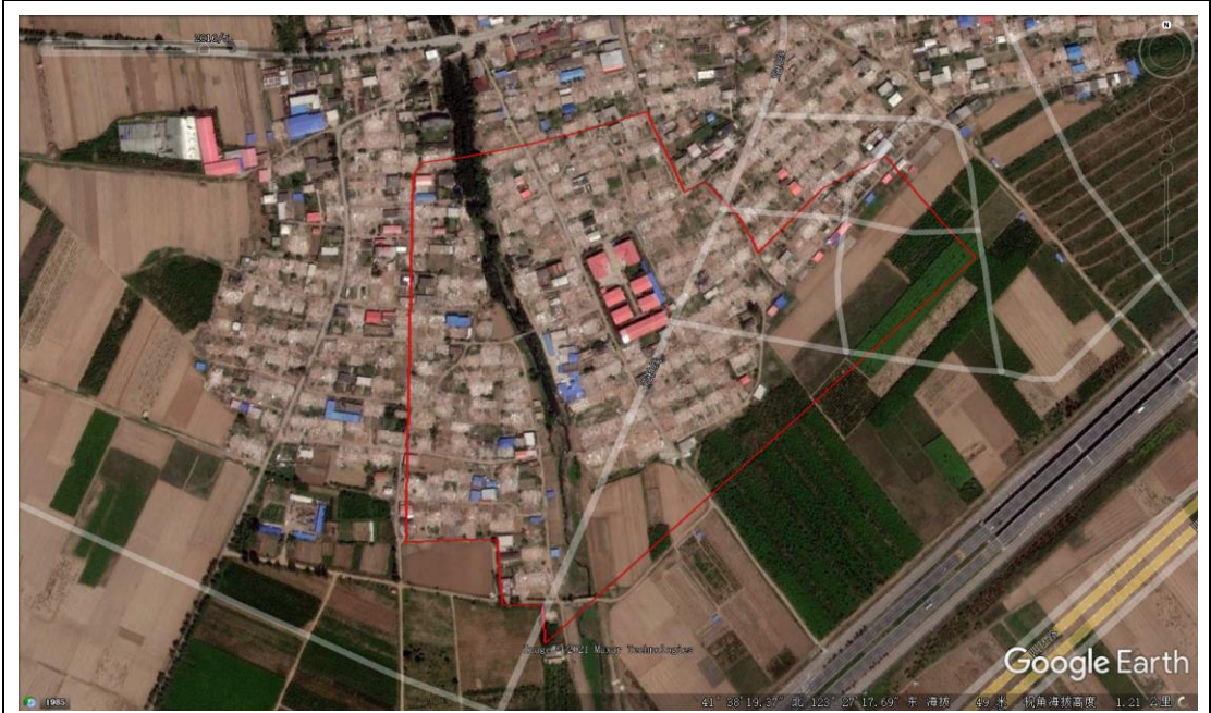
2016 年地块内住宅建筑逐步拆迁
